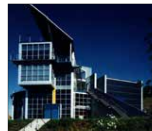
Außenansicht des Instituts für Solarenergieforschung
